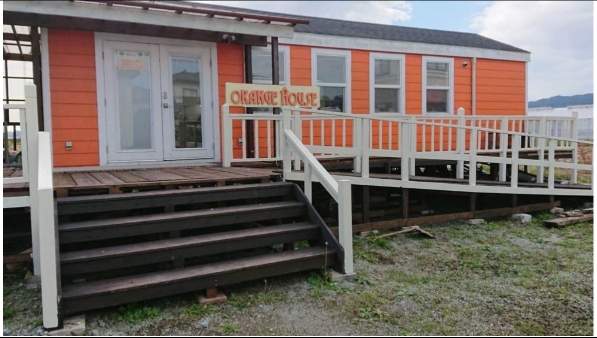
デッキとスロープの修理が完成（2021年10月撮影、以下同様）
