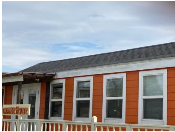
屋根がきれいに直り、不安がなくなったオレンジハウス
