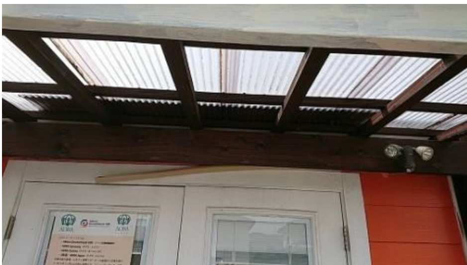
修理前の様子（2022年5月撮影）
