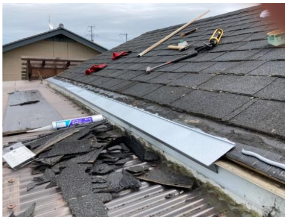
修理中の様子
