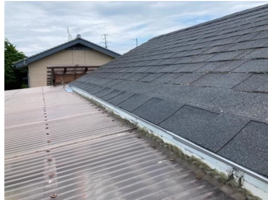
修理後の様子
